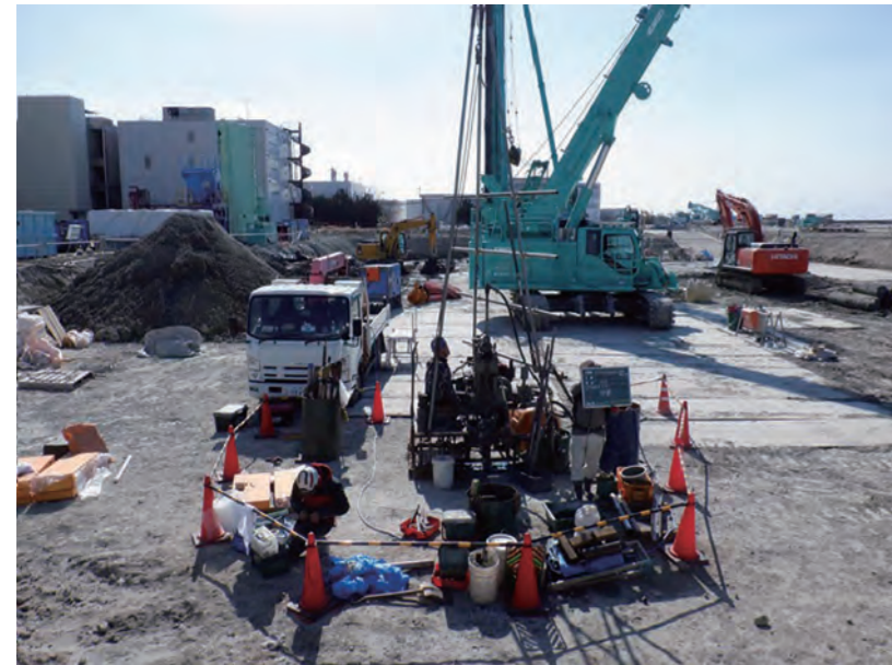
▲全長コアボーリングの実施状況（杭No.2A-9）
