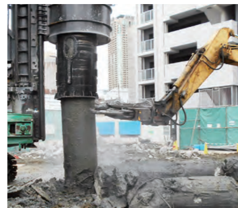
▲杭を切りながら排出します
