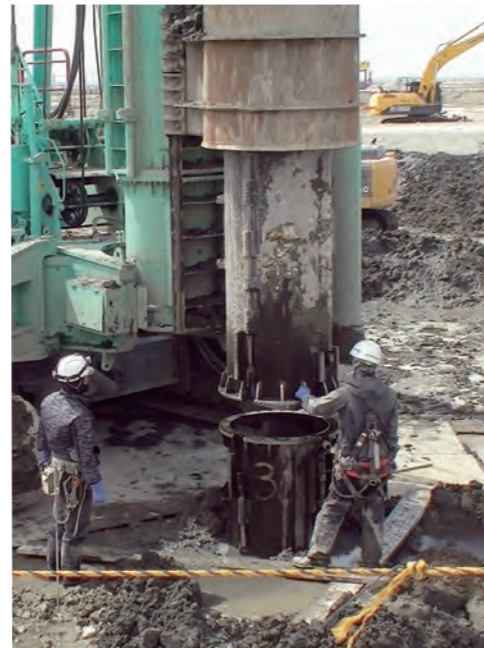
引き上げ時 ③露出した杭を切断する
