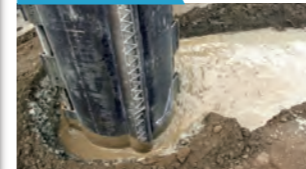
⑤ 引き上げ注入
