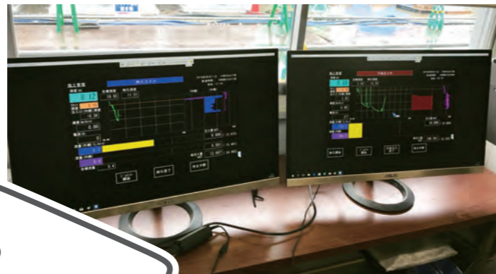
現場事務所の遠隔モニター▲
