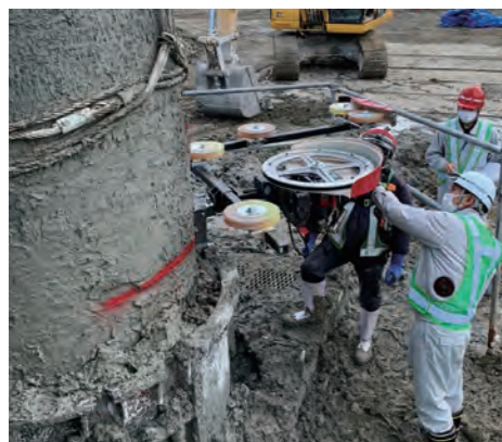
▲ワイヤーソーによる杭の切断
