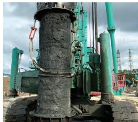
▲大口徑杭専用の吊り具
